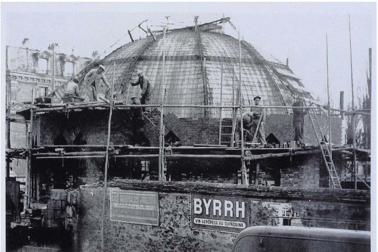
La construction de la coupole.
