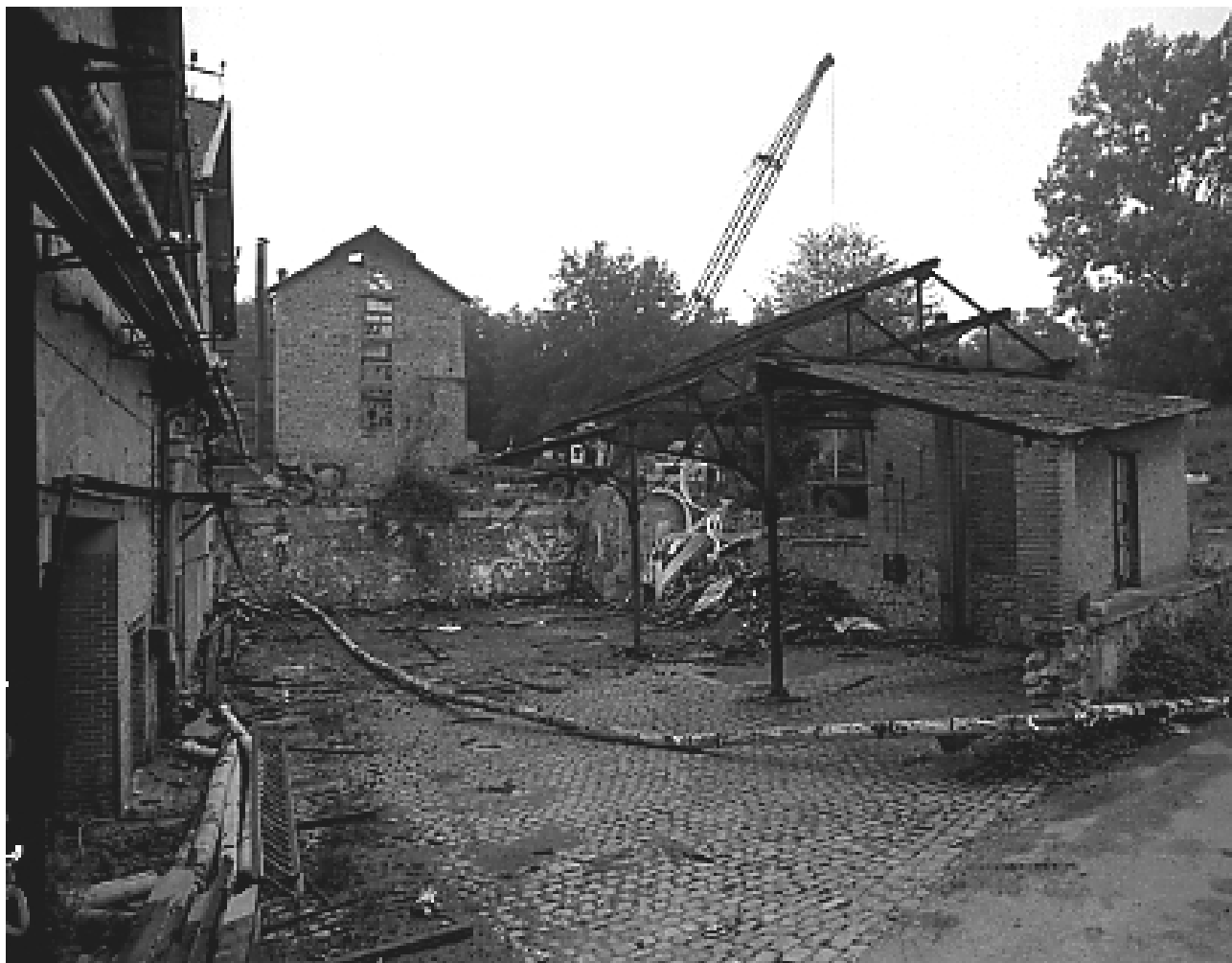
Fig.8 Anciens dépôts, construit en 1925. Le bâtiment de gauche a été aménagé pour abriter 4 cuves en béton, et au niveau inférieur, 6 cuves de 250 hl en béton. Dans le bâtiment de droite, stockage et bureau de contrôle des chargements. Au premier plan, un quai de chargement.
