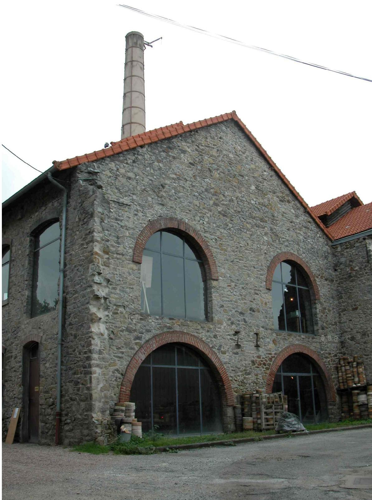
Fig.8 Pignon Nord-Est du bâtiment du four des Casseaux. Les grandes ouvertures couvertes en plein cintre donnaient accès à un bâtiment de four accolé, aujourd'hui disparu.
