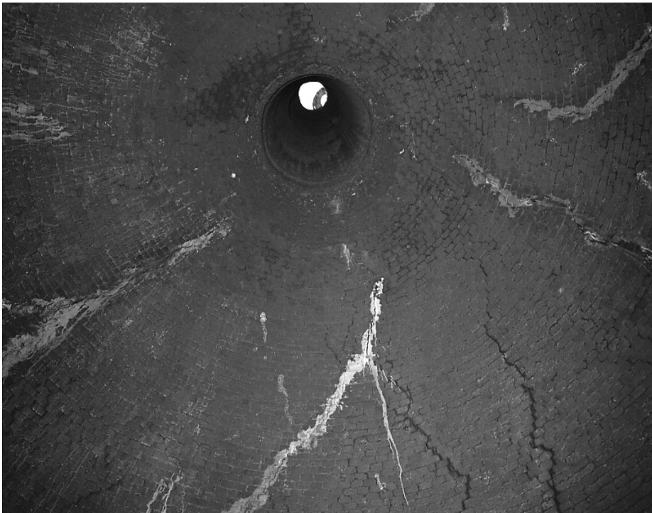
Fig.21 Vue intérieure de la voûte du globe du four des Casseaux, et orifice du conduit de cheminée.
