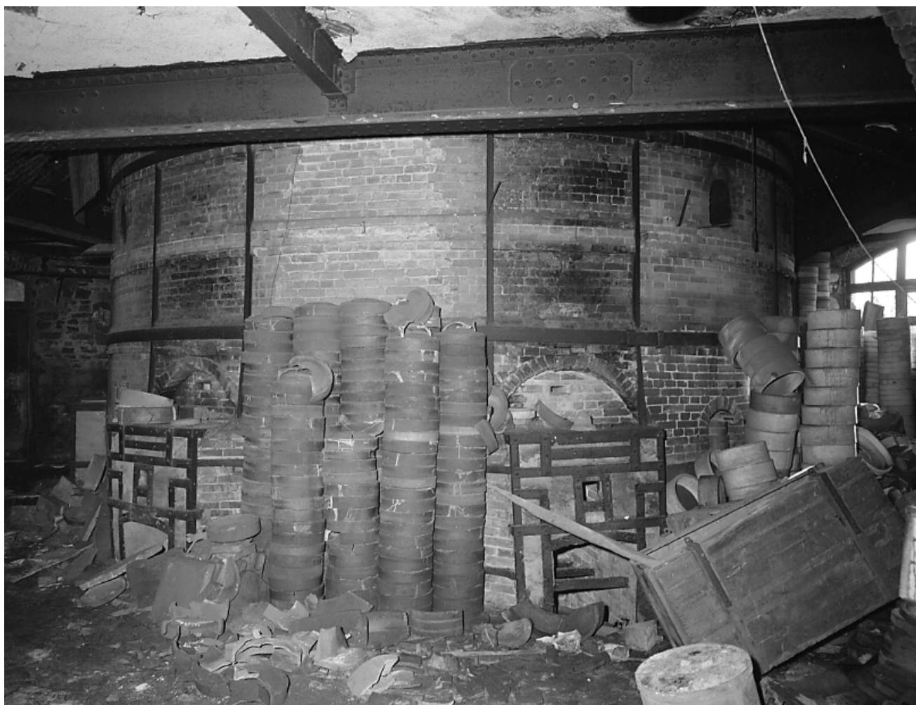
Fig.9 Le four des Casseaux avant son dégagement (niveau du laboratoire, rez-de-chaussée) : des piles de gazettes adossées à la chemise du four, entre deux alandiers.
