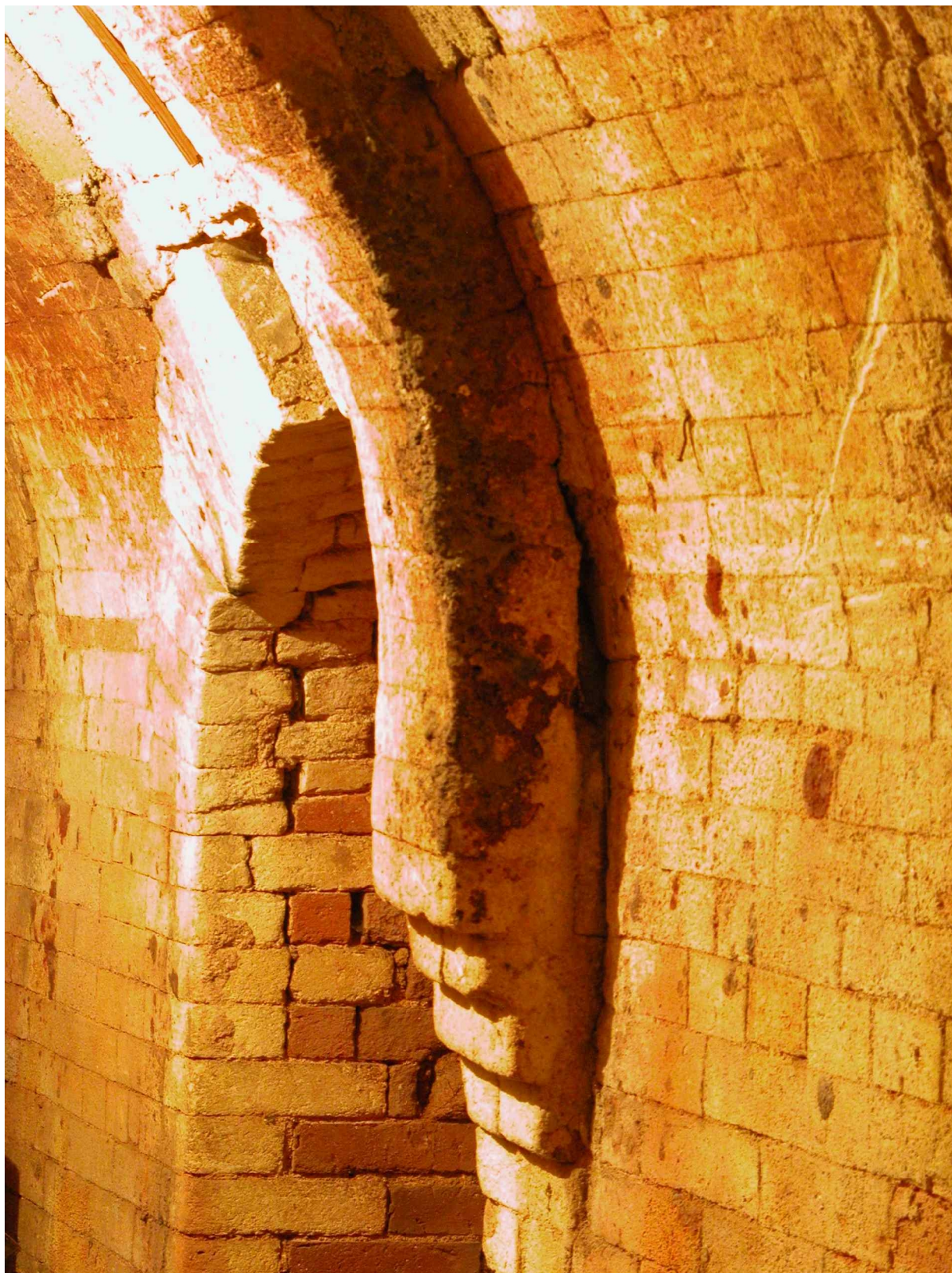
Fig.7 Détail de la voûte du four tunnel Nord.
