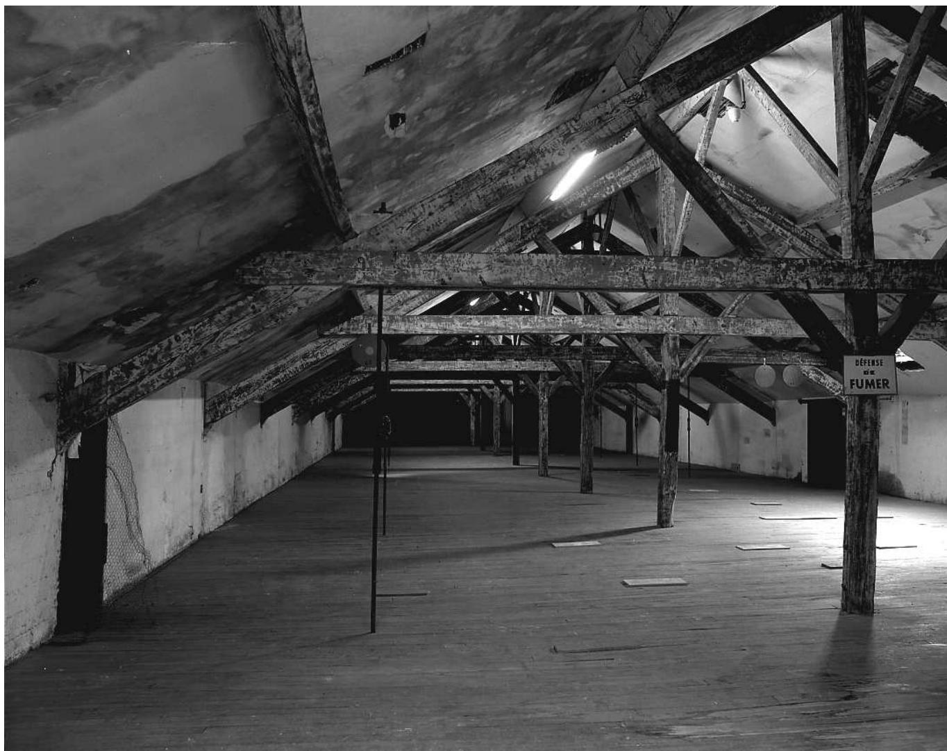
Fig.14 Charpente des comble, au niveau l'articulation des ailes Nord et Sud des ateliers.
