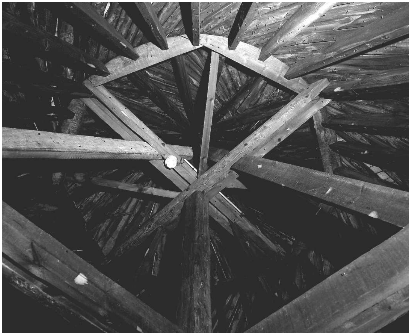
Fig.16 Charpente du dôme de la tour d'escalier.
