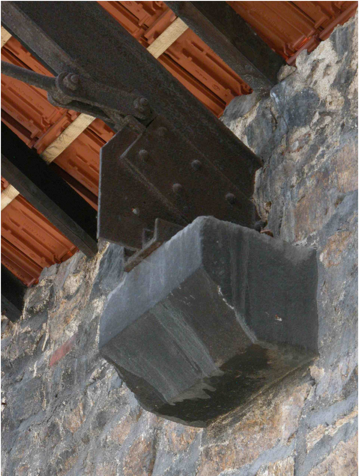
Fig.39 Ancien bâtiment de four construit durant le dernier quart du 19e siècle, reconverti en entrepôt de gros moules. Vue de détail d'un corbeau de pierre portant une ferme métallique.
