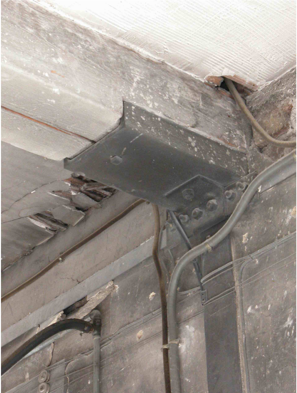
Fig.30 Atelier de façonnage : détail de la liaison entre le pan de fer et les poutres du plancher en bois.
