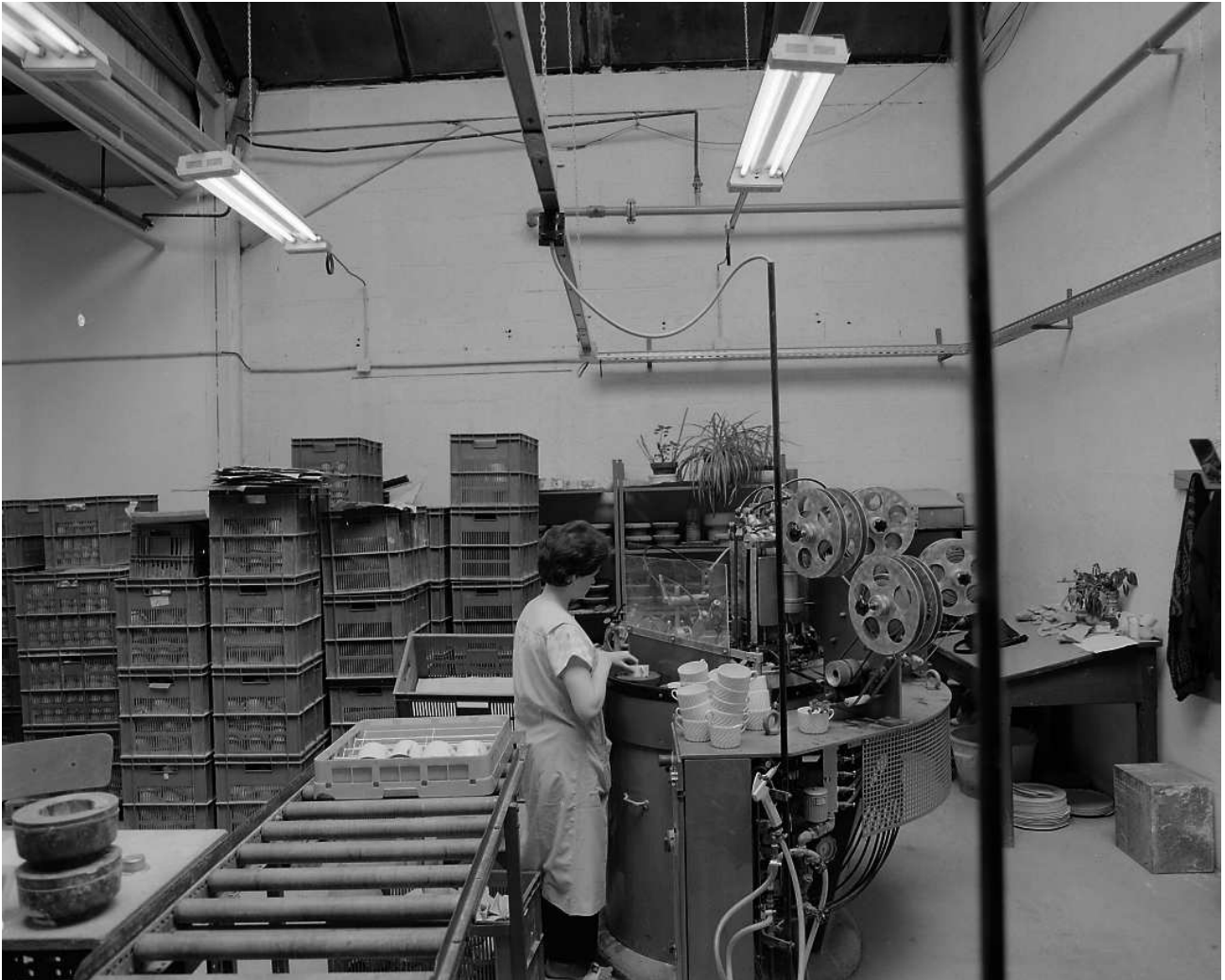
Fig.62 Atelier de finition du blanc : polissage du bord des tasses (produit fini).
