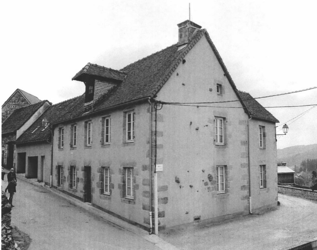
Fig. 2 Rue du Bouquet. Vue d'ensemble d'un atelier de tapisserie ayant sans doute appartenu à M. Bacaud. La mise en oeuvre est marquée par les changements industriels de la fin du 19e siècle: alternance de granit et de brique, fenêtrage important.
