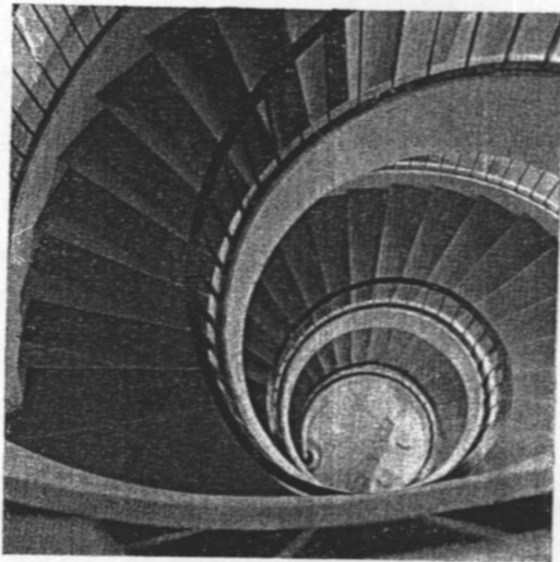
Aspect d'un des escaliers.
